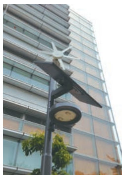
W10号館(薬学部棟)横
